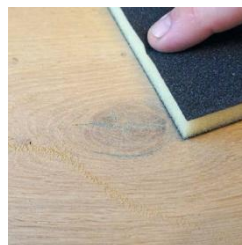
Произвести шлифовку дефекта
